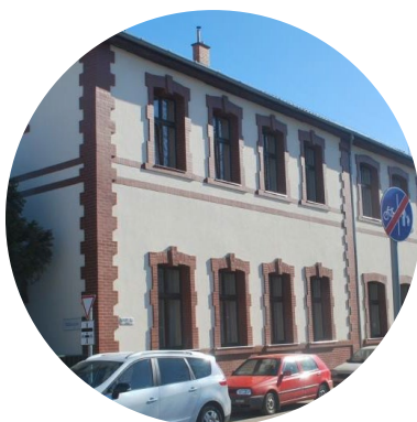
Római katolikus iskola radiátorok
