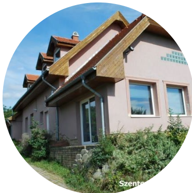
Családi ház padló és radiátorfűtéssel
