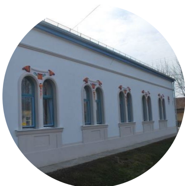
Tulipánkert óvoda radiátorfűtés
